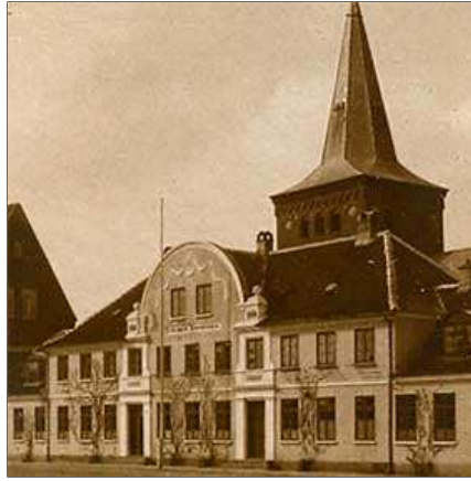
Sakskøbing Borgerskole 1847-1965 med til- og ombygning 1912
