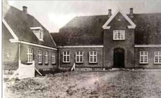
Soesmarke Skole, Guldborgvej 228, opført 1917. Samtidig foto
