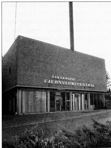
Fjernvarmecentralen, hvor driften var baseret på olie.
