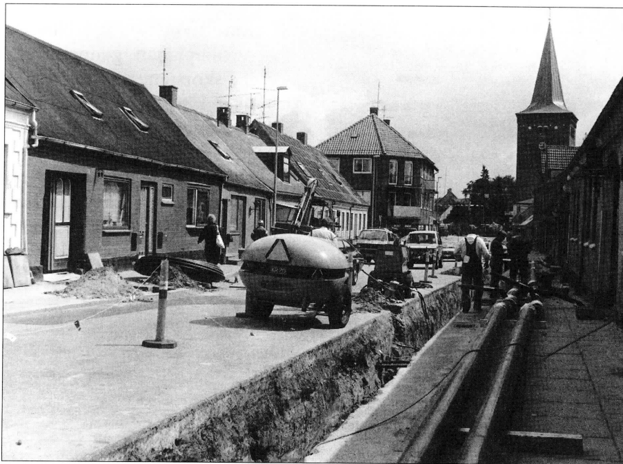
Nedlægning af fjernvarmerør.
