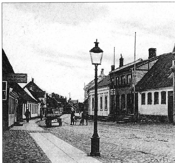
Gaslygte i Søndergade
