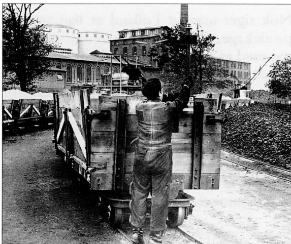
Slutsignalet "Polakken" sættes på plads.
