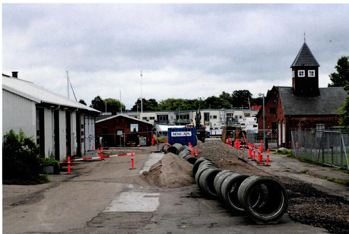
Renovering af kloakledninger i Emil Aarestrups Gade
