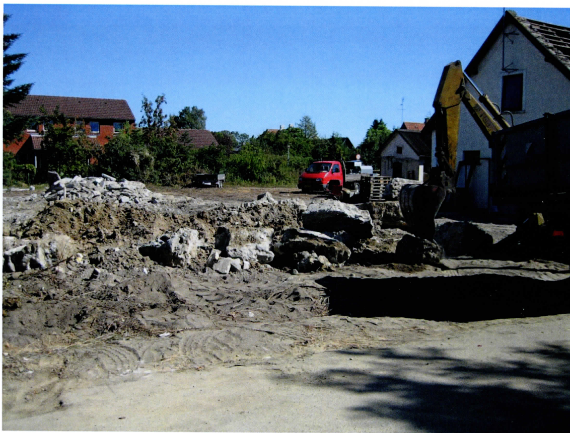
Nedrivning af bygningerne på Nyvej i 2009
