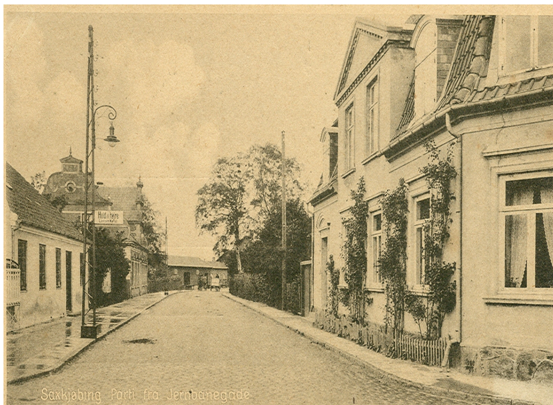
”Jernbanehotellet”, Jernbanegade 9 er huset til højre, billede ca. 1918.
